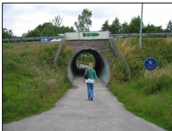
Gång- och cykeltunnel under Överbyvägen. Vy från söder.
