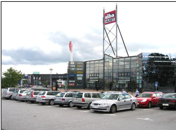
Siba-huset i Överby Södra. Vy från nordväst.
