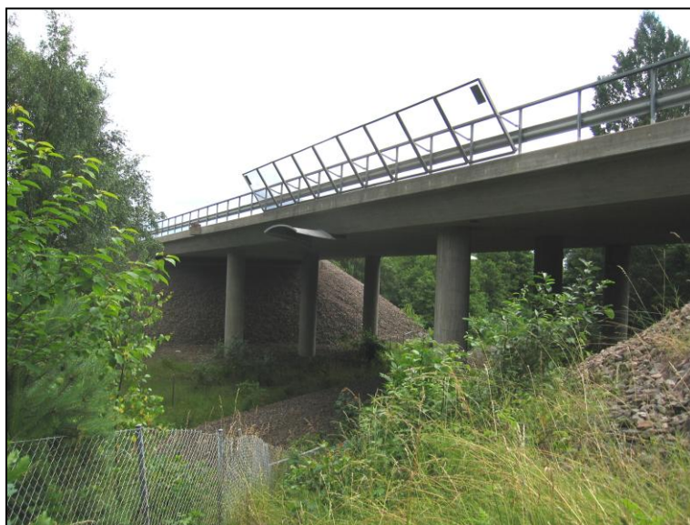
Den f.d. järnvägssporten under E 45/väg 44. Vy från nordost.
