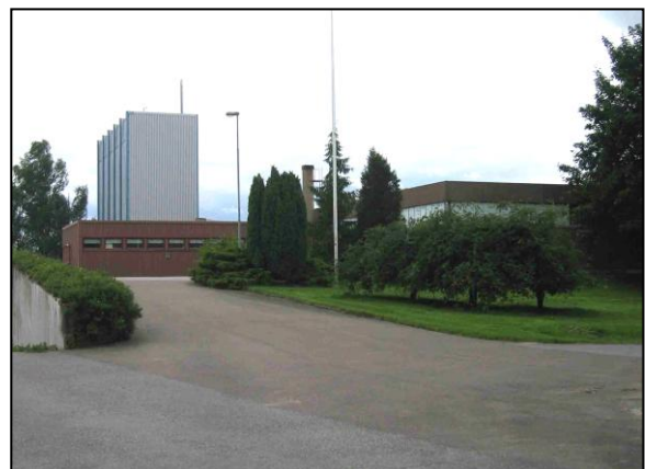
Trollhättans vattenverk i Överby Östra. Vy från nordväst.
