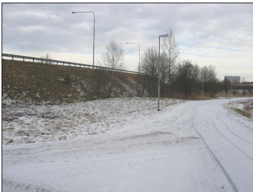
Överbyvägens vägbank. Vy från sydväst.
